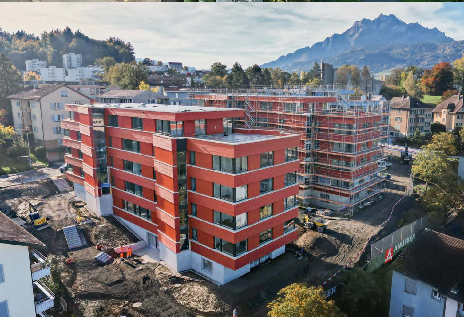
Weinberglistrasse 74, 2018 (oben) und nach Entfernung des Fassadengerüsts, 2021 (unten)
