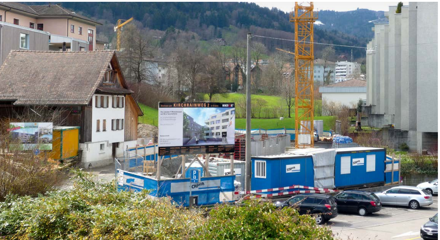
Kirchrainweg, Kriens, Baustelle, 2013
